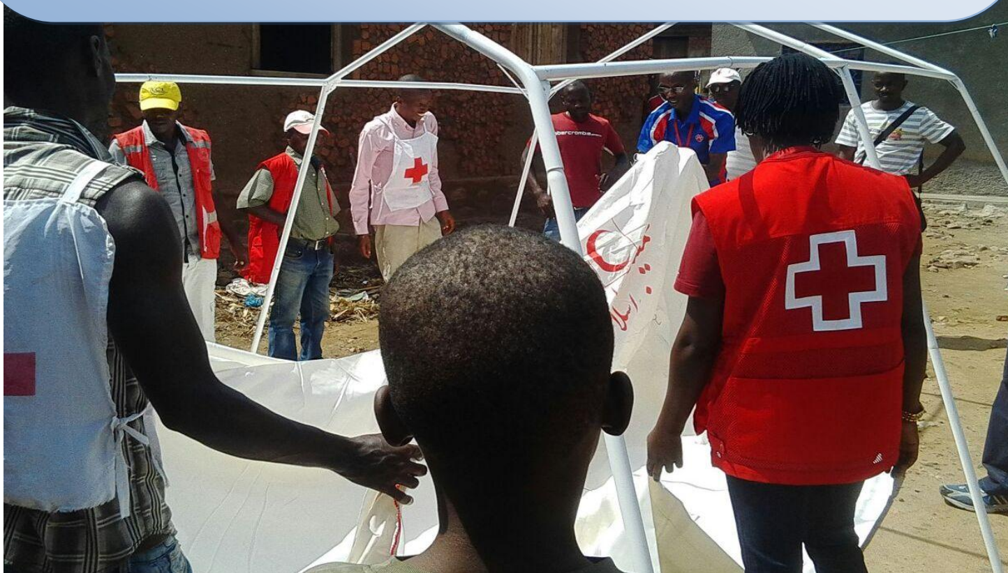
Construction d'abris pour les victimes des inondations
